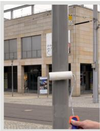
Die Spezialbeschichtung ist einfach zu verarbeiten. Mit der Kurzflorwalze aufrollen oder mit dem Pinsel.
