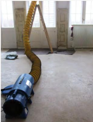
Der Einsatz einer technischen Belüftung ist im Bedarfsfall zu empfehlen.
